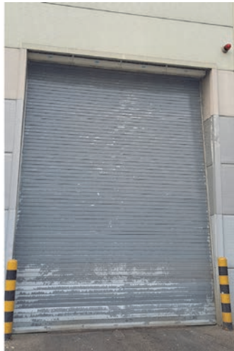
[그림 4.3] 반입장 에어커튼 및 고속전동셔터 예시
