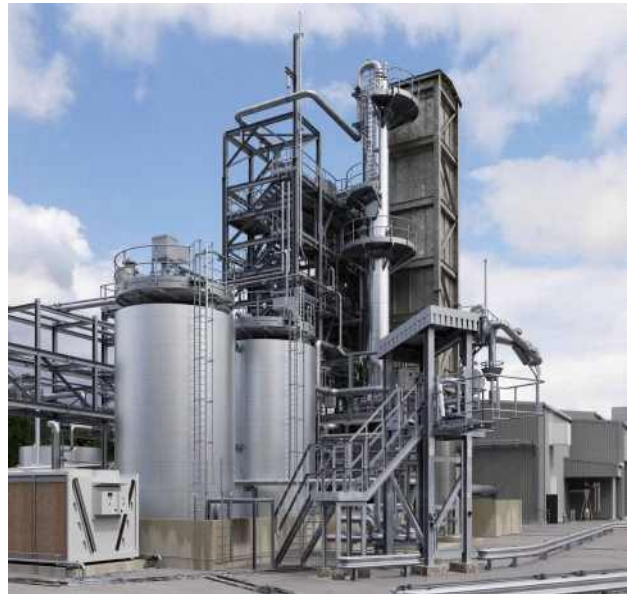
<무라윌튼 시설 전경>
