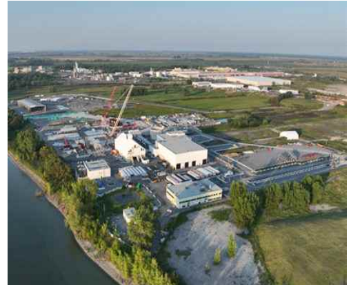
< VCR 시설 전경 >
