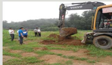
굴착을 통해 사업장부지 매립폐기물 확인(허가기관 및 토지주 입회)
